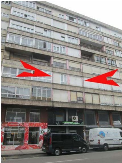
Cuatro metros de frente de fachada
