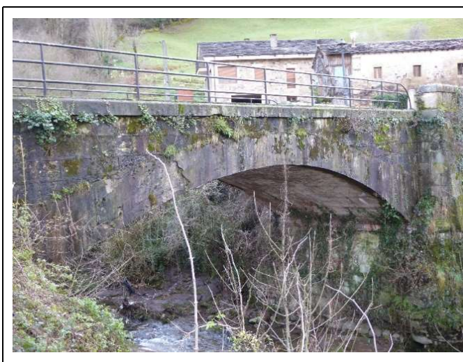
El puente sobre el río Yera en Vega de Pas fue reconstruido, después de su destrucción en 1937, durante la guerra civil, con bóveda de hormigón sobre los estribos pétreos primigenios (LVC).
