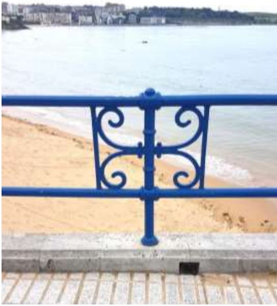
Fotos comparativas del elemento central de hierro fundido en la original, y la nueva barandilla realizada soldando los tubos. Se pueden comparar los adornos centrales.
