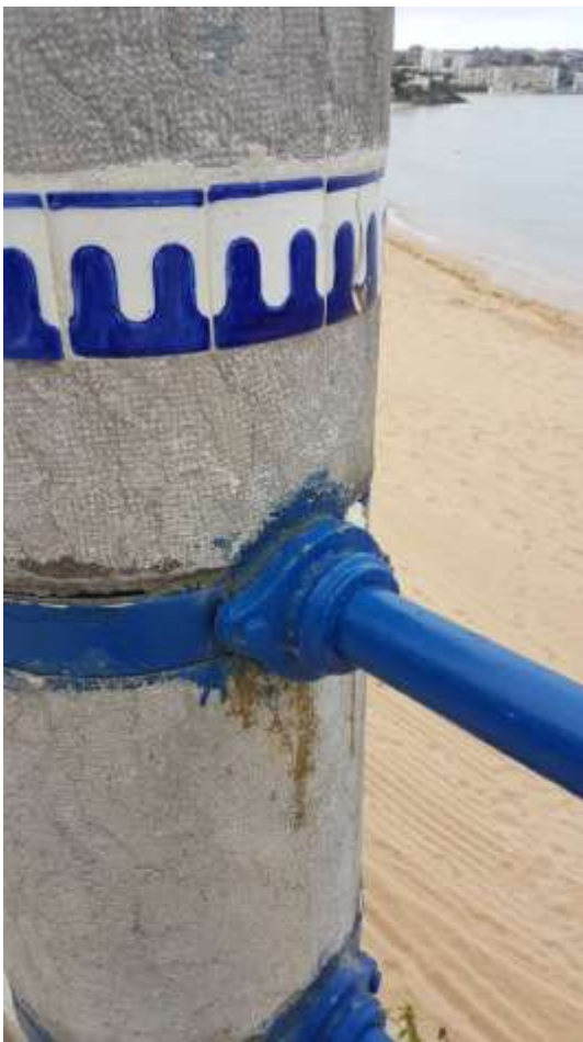
Fotos comparativas entre la pieza de fundición original donde se insertan los tubos, y el nuevo tapajuntas que tapanía la unión soldada, en el encuentro con los pilonos de piedra
